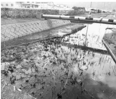
中野町の承水路の現状
