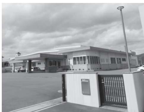
境港市学校給食センター
