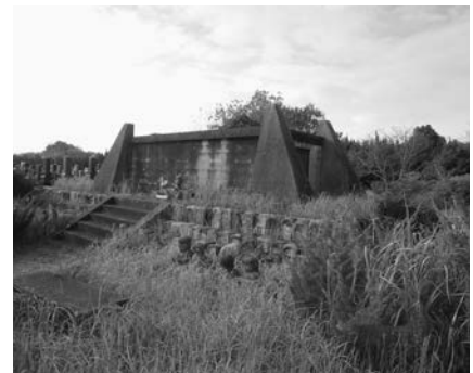
納骨堂及び周辺の状況
