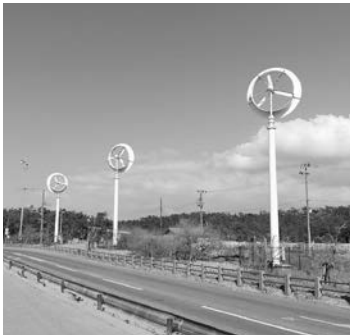
小型風力発電設備の一つの例
