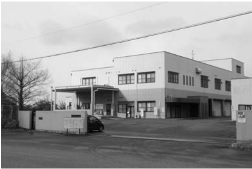
不燃ごみなどを処理する リサイクルセンター (ごみ処理の広域化が計画されており、 施設撤去の予定)
