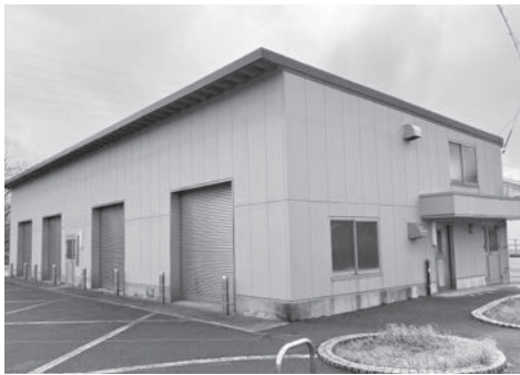
余子駅前にある防災備蓄倉庫
