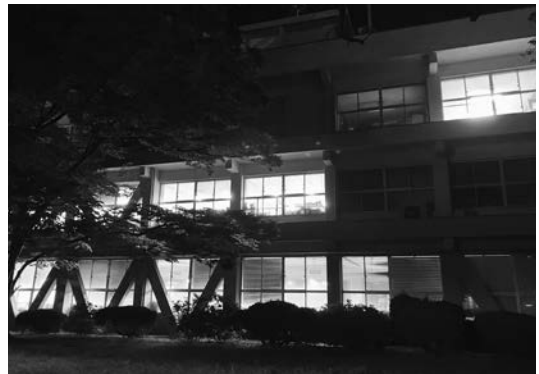
夜遅くまで明かりの灯る市役所本庁舎
