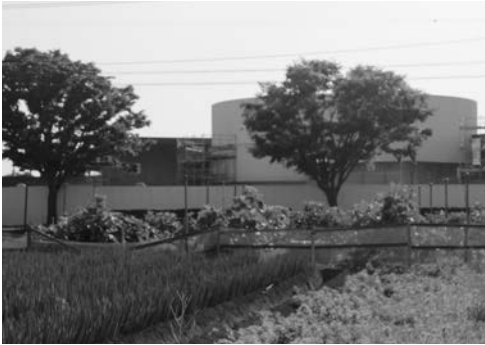
回廊の解体が進む文化ホール
