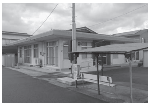
美保町会館（令和7年度耐震診断予定）
