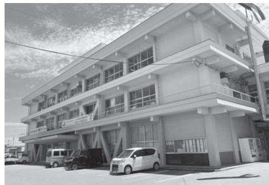
建築後60年以上が経過し 建て替えが検討される本市の庁舎
